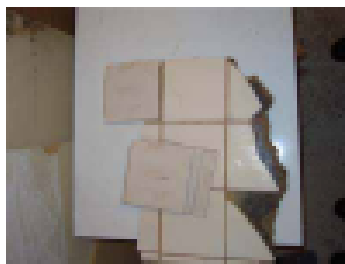
Bituliitin päälle laatoitettu
