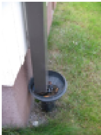
Sadevedet ohjataan omiin kaivoihinsa
