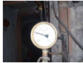
Mittarilukemaa tulee seurata ja vettä lisätä vain hyvin harkiten
