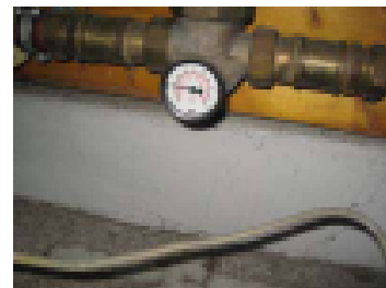
Painemittari käyttövedessä
