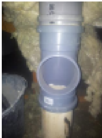
Puhdistusluukuista viemärit päästään kuvaamaan
