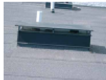
Sadekatos ilmanvaihtohormien päällä
