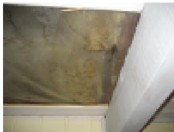
Eristeet kellarin seinän sisäpuolelta poistetaan
