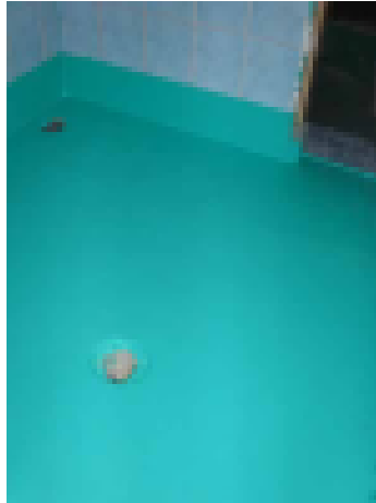
Uusi vedeneriste odottaa laatoittamista
