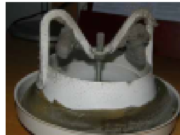
Likaiset poistoilmaventtiilit tulee puhdistaa kaksi kertaa vuodessa
