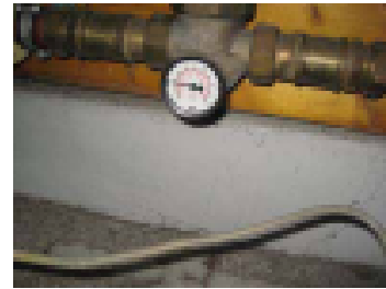
Painemittari käyttövedessä
