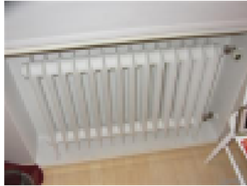
Patteriventtiilit ja termostaatit ikääntyvät 10 vuodessa
