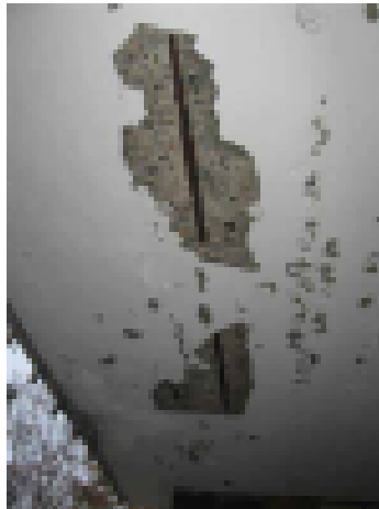
Parvekelaatan alapinnan teräs
