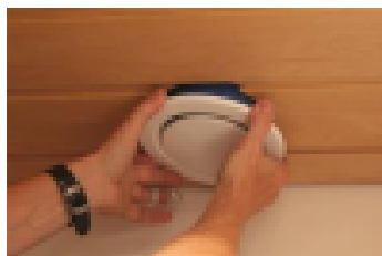
Venttiili avataan pyörittämällä kehystä vastapäivään
