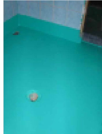
Uusi vedeneriste odottaa laatoittamista
