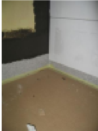
Vedeneristys tehdään kauttaltaan koko märkätilaan
